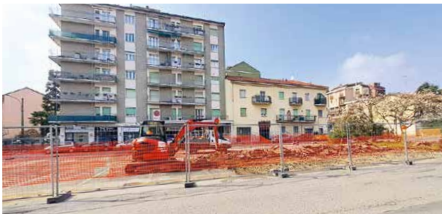
Lavori in Piazza Martiri della Libertà
