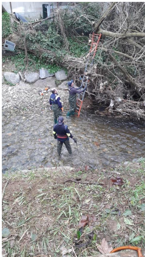
Intervento di sgombero Fiume Seveso – Protezione civile
